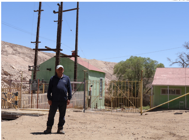
ÚLTIMO OPERADOR. Marco Ortiz es el último operador de la Hidroeléctrica Enaex que podría cesar sus funciones pronto. Aquí también funcionó un camping.
